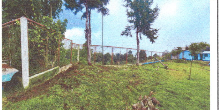
Foto 6: reparación de muro perimetral de block con tubo ng y malla garbanizada, soleras intermedias y columnas.
