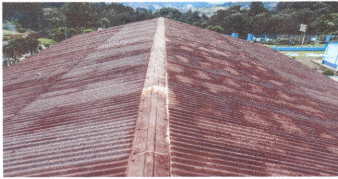
FOTO 1. Sustitucion de lámina, por lámina troquelada calibre 26, sustitucion de capote de lámina para lámina troquelada, sustitución de elementos de fijación. Modulo 1 de aulas.
