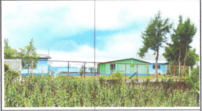
Foto 8: reparación de muro perimetral de block con tubo ng y malla garbanizada, soleras intermedias y columnas.
