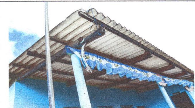
Foto 3: sustitución de estructura de soporte de madera, por metal modulo 2 de aulas.
