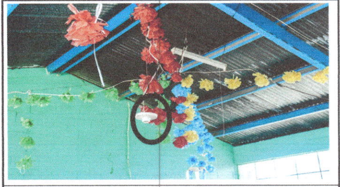
Foto 10: sustitución de foco ahorrador modulo 1 de aulas.
