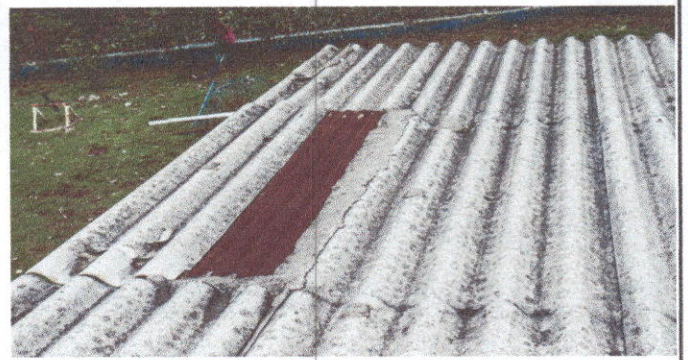
Foto 2: Sustitucion de lámina, por lámina troquelada calibre 26, sustitucion de capote de lámina para lámina troquelada, sustitución de elementos de fijación. Modulo 2 de aulas.
